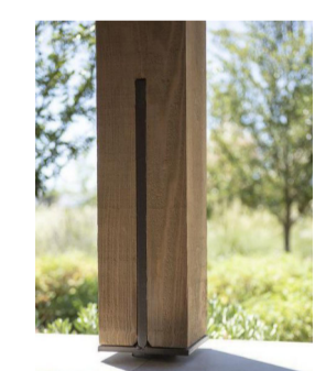
DETALHE DE FIXAÇÃO - PERGOLADO ESCALA 1:25
