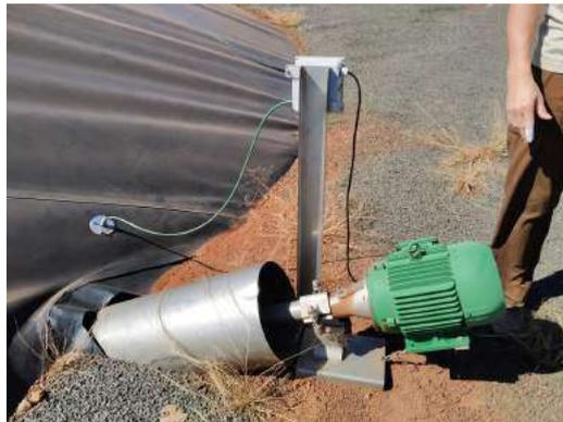
Figura 7: Exemplo de acesso para agitação e limpeza/remoção de lodo
