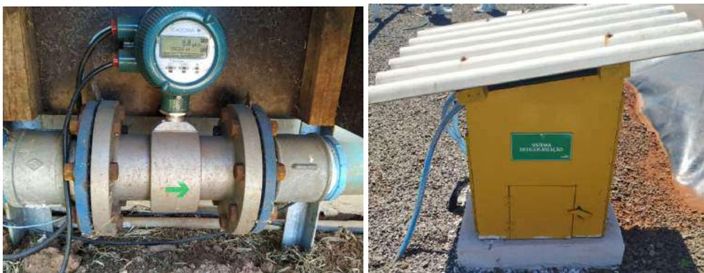
Figura 8: Abrigo medidor de vazão
