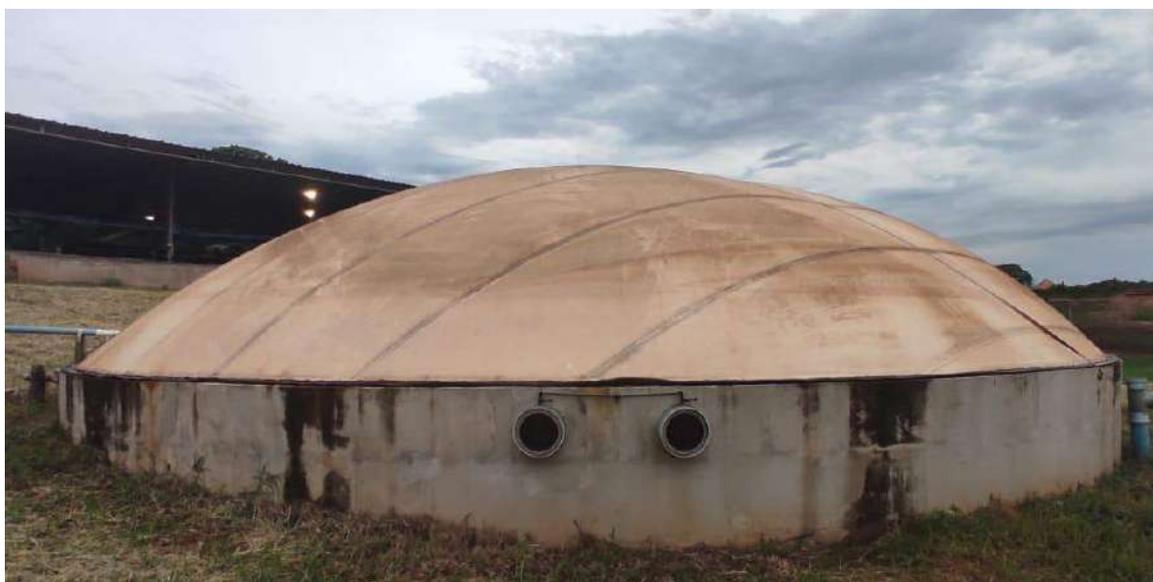
Figura 2: Exemplo de janelas de inspeção.
