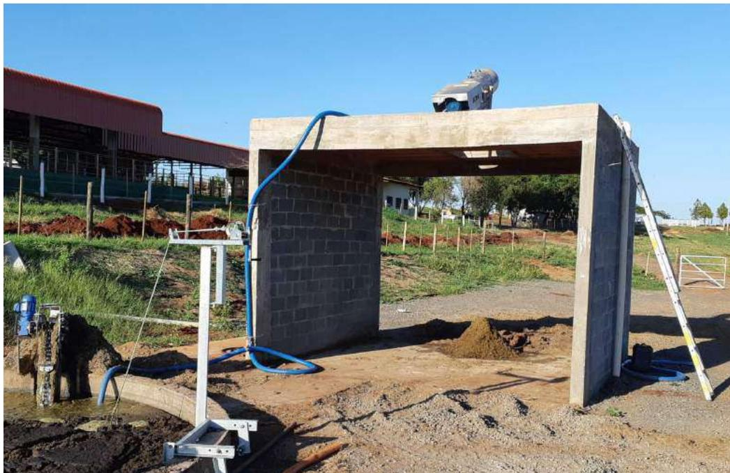
Figura 12: Exemplo de estrutura elevada sem cobertura para separação de sólidos.
