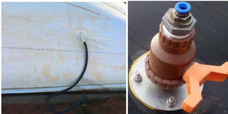
Figura 5: acesso para inserção de ar e análise de biogás com engate rápido.
