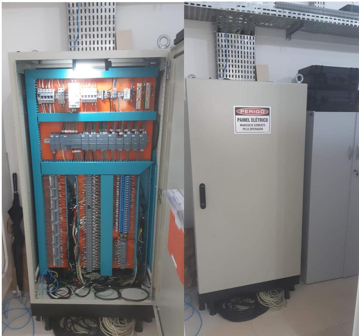
OBS: Afastamento do piso de 12 cm com pés e aberturas no painel para passagem de cabos<sup>1</sup>.
