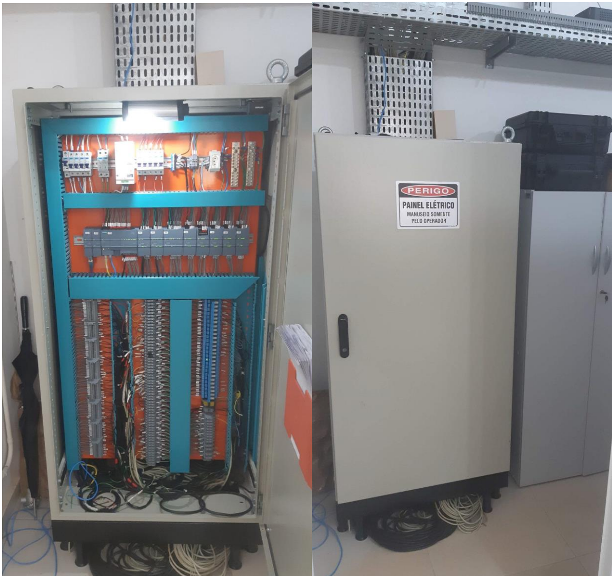
Figura 01 - Painel existente e espaço para o painel novo (armário)
